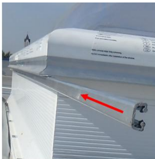
Rys. 41. Nasuwanie łącznika.
