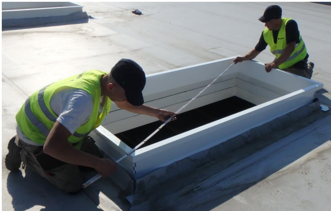
Rys. 29. Sprawdzanie przekątnych.
