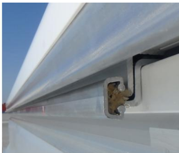
Rys. 43. Zawias z zamontowanym łącznikiem.
