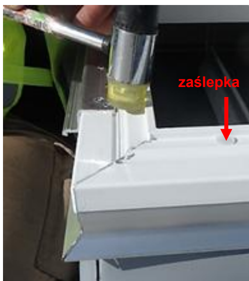
Rys. 36. Montaż zaślepek w wieńcu PVC.
