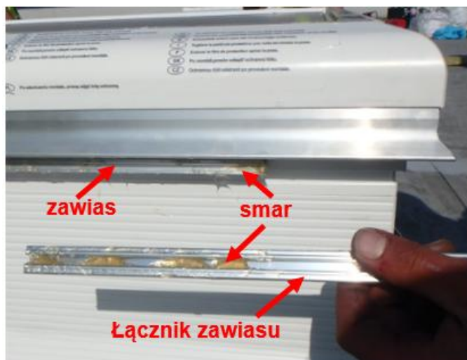
Rys. 40. Smarowanie zawiasu.
