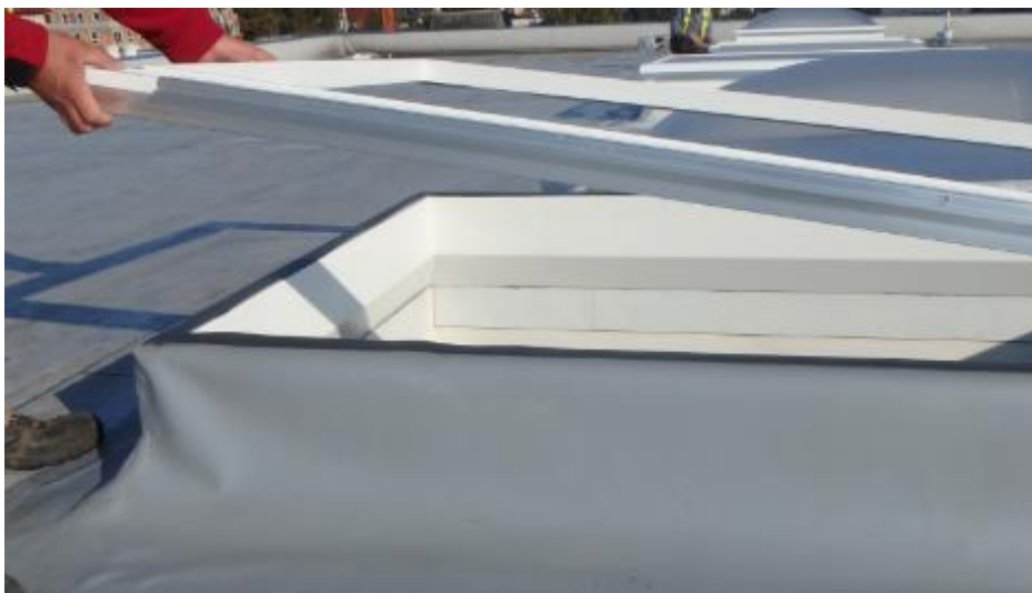
Rys. 34. Układanie wieńca PVC na uszczelce PES.
