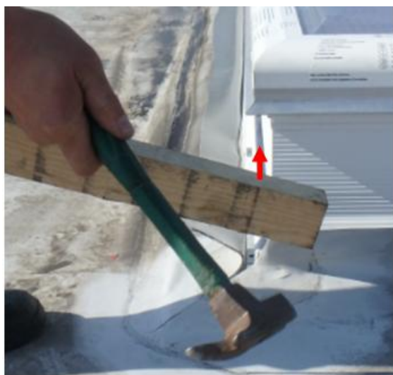
Rys. 42. Nabijanie łącznika.
