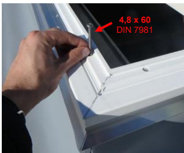
Rys. 35. Przykręcanie wieńca PCA do podstawy metalowej.
