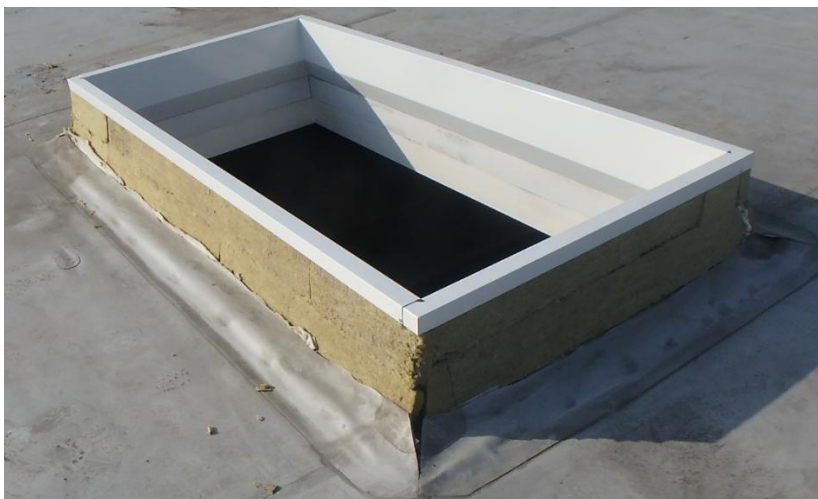
Rys. 31. Ocieplona podstawa (grubość izolacji wynosi 50 mm).
